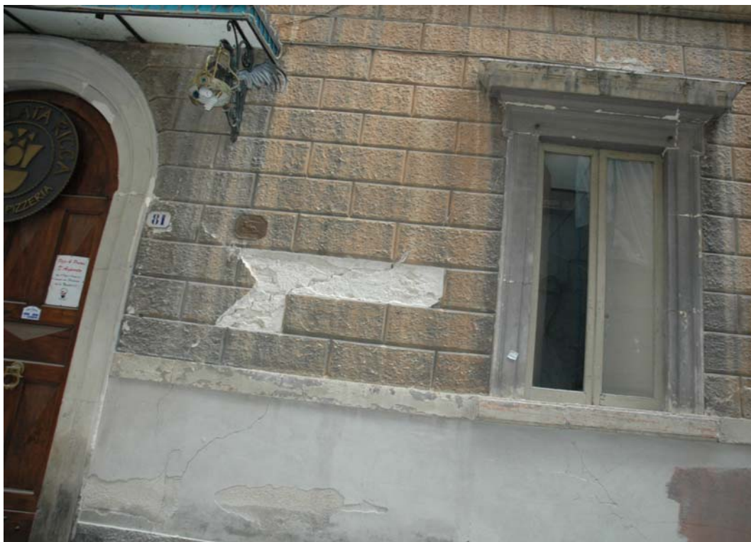
Figura 9. Lesione in un pannello murario di facciata (by A. Balsamo, I. Iovinella, A. Prota)
