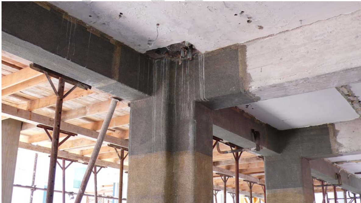
Figura 79. Rinforzo a taglio continuo con compositi di una trave interna in c.a. con fioccatore di ancoraggio
