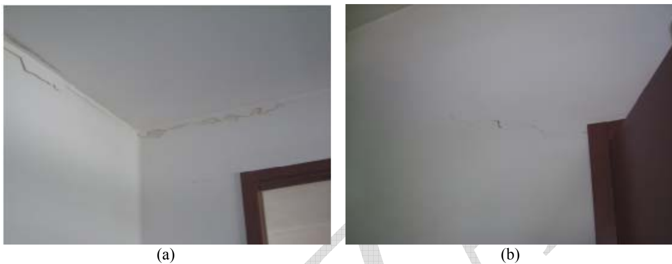
Figura 15. Danni alle partizioni: a) Lievi lesioni attacco tramezzatura-trave con parziale distacco intonaco; b) Lievi lesioni sui tramezzi in corrispondenza delle aperture (by D. Abbruzzese, R. Vittorini, F. Destefano, L. Miccoli, Z. Quian)
