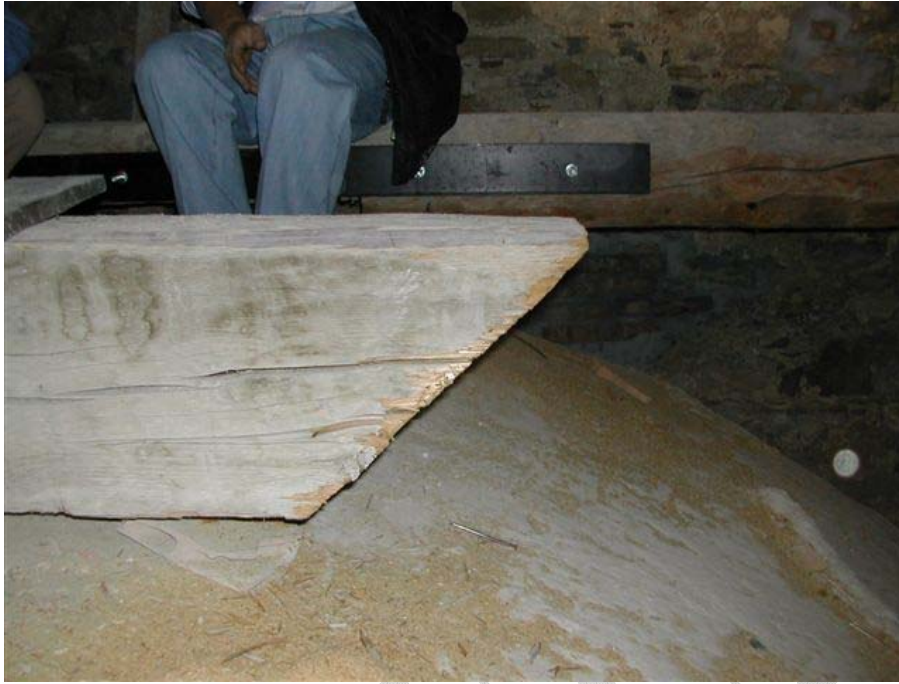
Figura 83. Ricostruzione dell'estremità di trave in legno appoggiata alla parete muraria mediante protesi di testata
