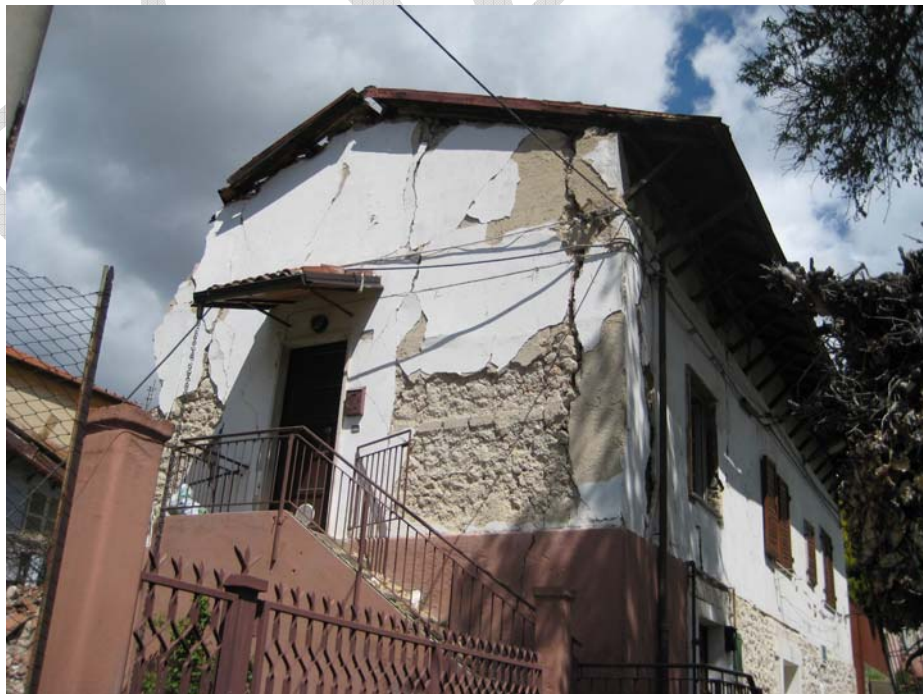
Figura 6. Lesione nel cantonale di un edificio in muratura (by A. Balsamo, I. Iovinella, A. Prota)
