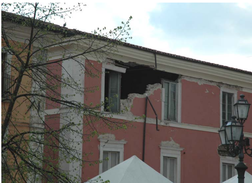
Figura 7. Crollo per ribaltamento fuori dal piano di pannello murario di sommità (by A. Balsamo, I. Iovinella, A. Prota)
