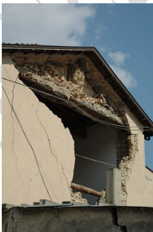
Figura 8. Crollo per ribaltamento fuori dal piano di parete perimetrale (by A. Balsamo, I. Iovinella, A. Prota)
